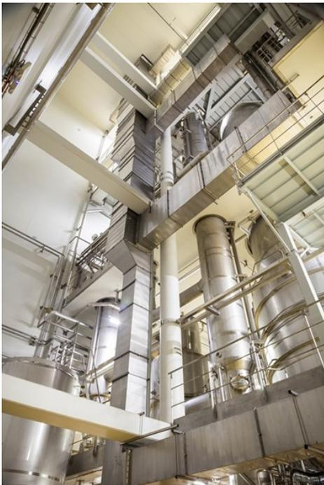
L'air est également préchauffé par un système de cogénération spécialement prévu pour ce processus.
