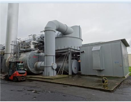
Les composés organiques volatils provenant du département d'extrusion sont brûlés dans un thermoréacteur. Les gaz de combustion chauds sont récupérés pour la production de vapeur.
